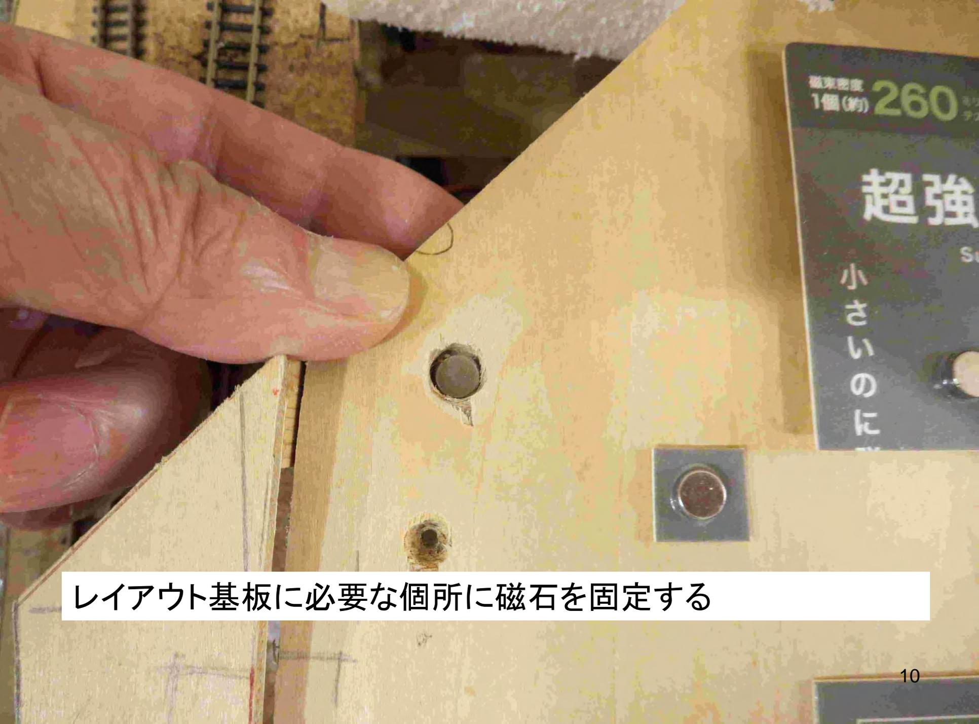
レイアウト基板に必要な個所に磁石を固定する
